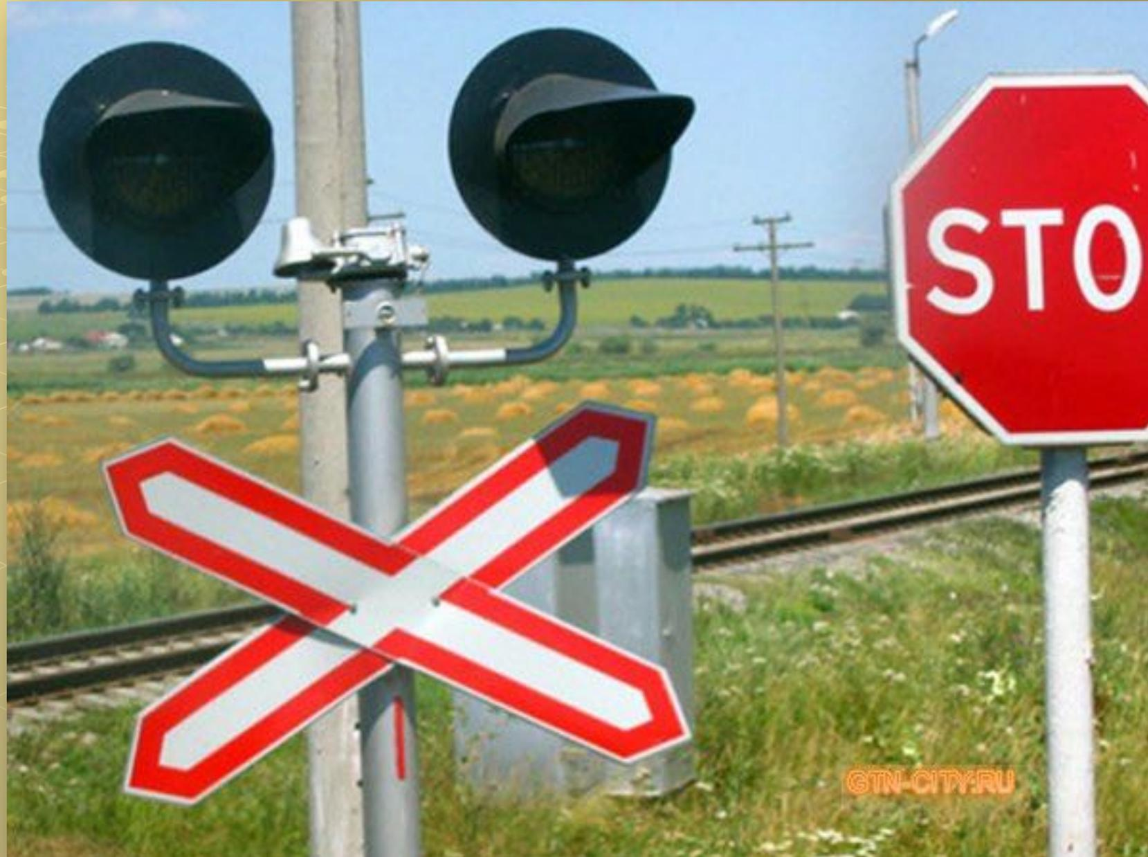
Два *попеременно мигающих красных фонаря* обозначают, что движение через переезд запрещено; данный сигнал обычно сопровождается *звуковой сигнализацией* (звонком).
